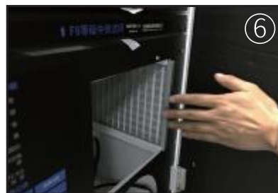
⑥ 将排风端初效滤网冲洗之后安装至原位
