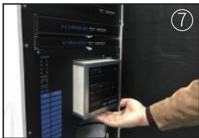
⑦ 将全热交换芯体安装至原位
