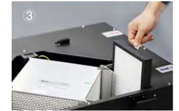
3、将新风端粗效滤网沿导轨垂直向上抽出
